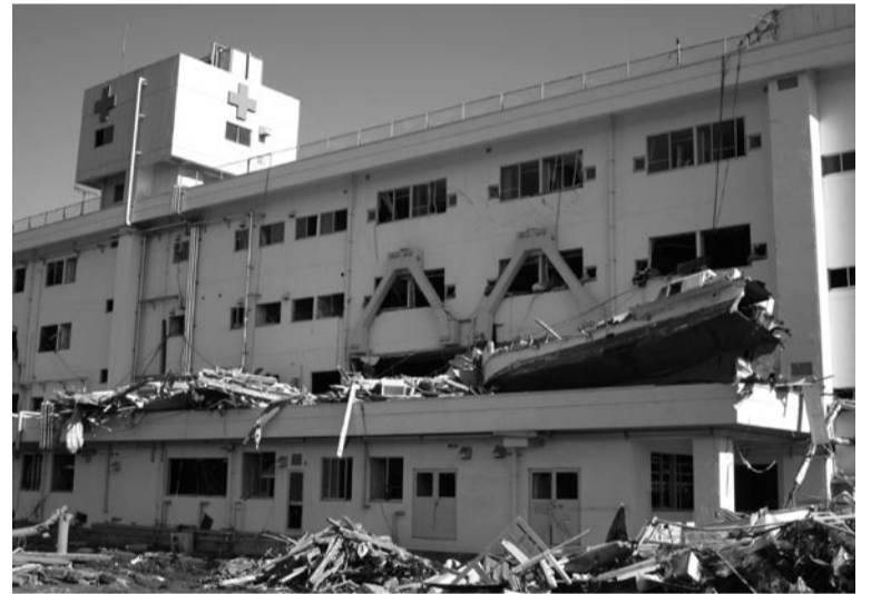
被災により取り壊された公立志津川病院
